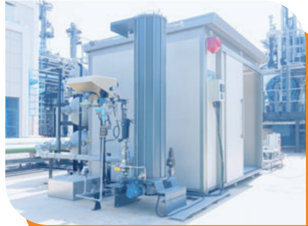
大埔煤氣廠設置供氫設施
