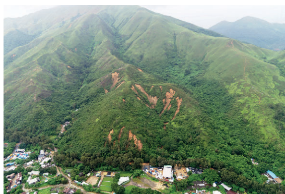
暴雨增加天然山坡的山泥傾瀉風險
