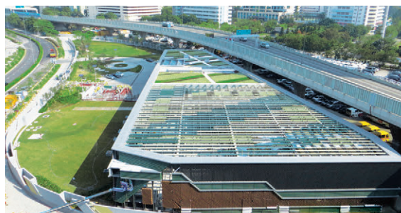
啟德發展區區域供冷系統
