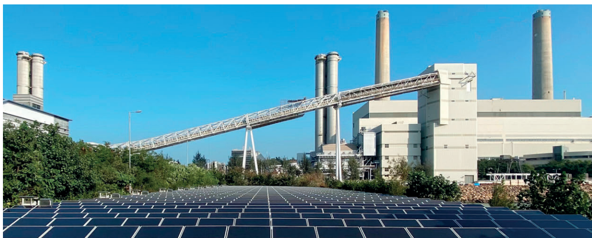
港燈在南丫發電廠安裝的太陽能發電系統
