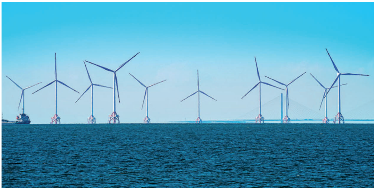
位於大灣區的離岸風力發電場
