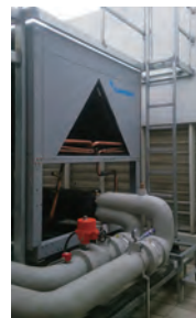
高效能氣冷式製冷機
